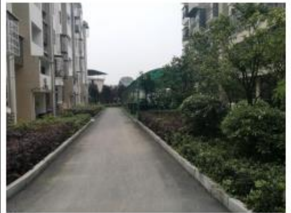
小区内园林绿化及硬化路面
