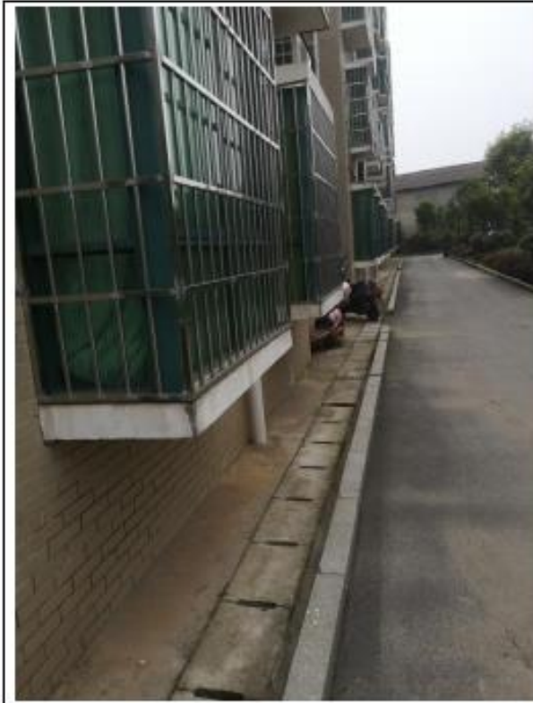
建筑物周边排水沟
