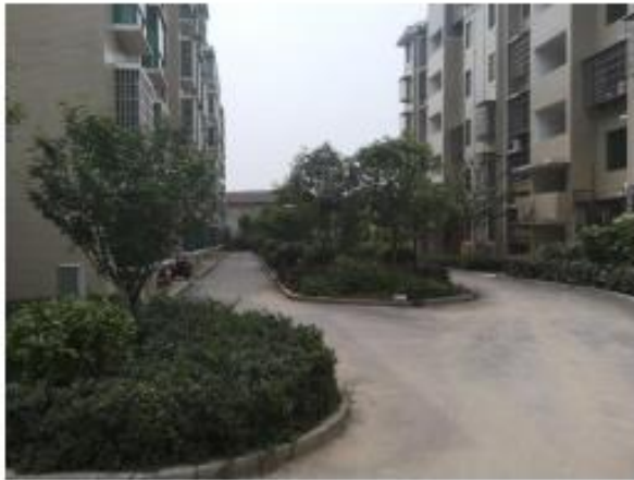
小区内园林绿化及硬化路面
