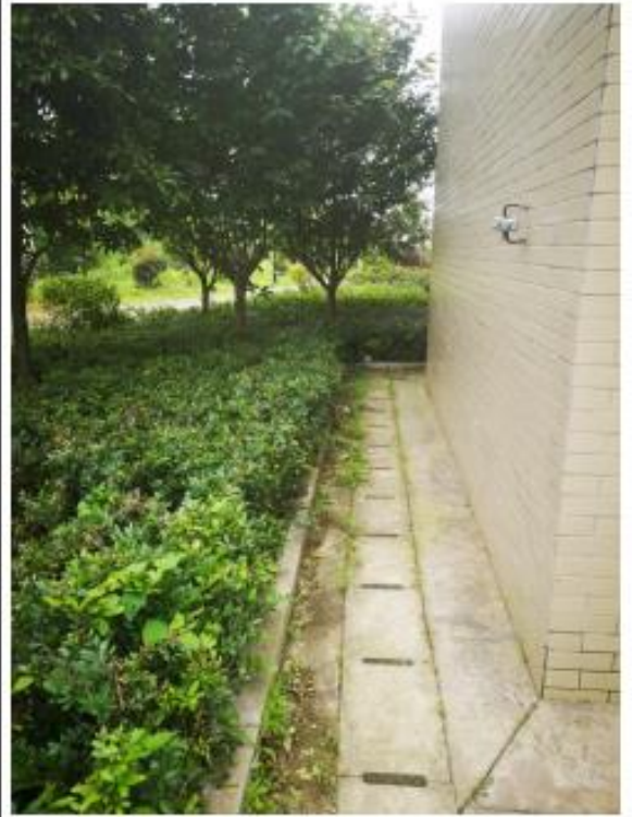
建筑物周边排水沟
